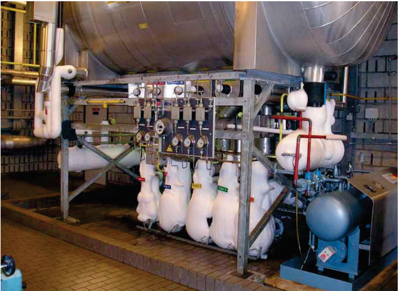
Ammoniakdroger aangesloten op lagedruk vat.
