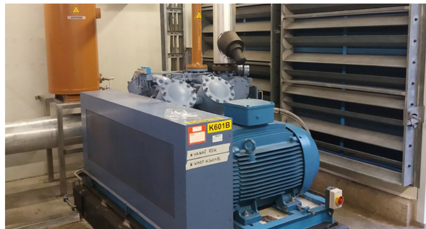
Plaats een olieafscheider niet pal voor geopende ventilatieroosters; dit kan tot koudemiddelcondensatie leiden.
