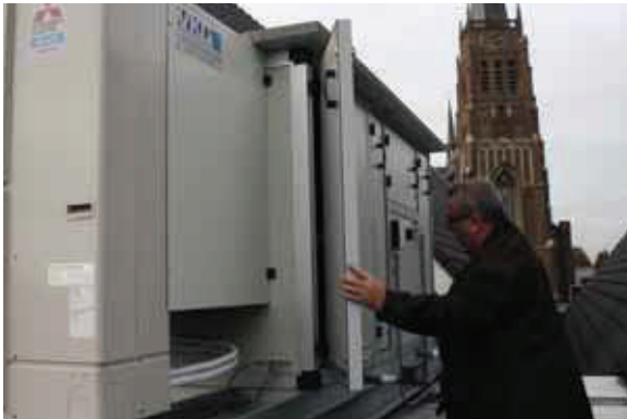
Theo Gijsbers op het dak bij een WTW-unit.
